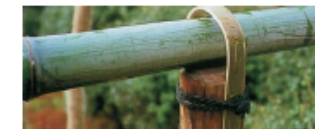
上：湖畔の車が見えないように青芝垣で。左：結界は竹と棒で一番簡単な竹垣。竹を薄くして、トンネル状に釘でとめる。
